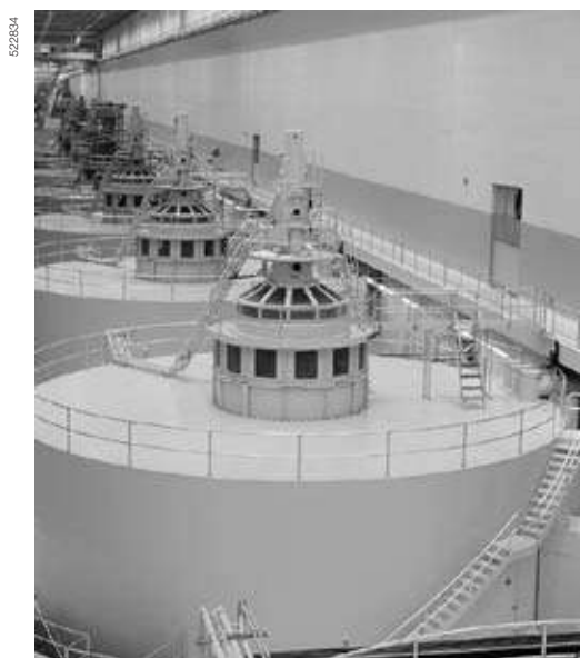
Aplicación de bombeo
